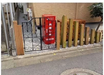
写真にある赤い「火消し箱」にスタンドパイプ本体、消火栓鍵、ホース、管そう（筒先）などが入っています。
